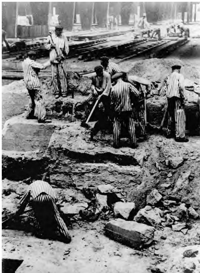
Tschechische Häftlinge zerlegen Betonfundamente im Klinkerwerk, SS-Foto, um 1940. Foto: Stiftung Brandenburgische Gedenkstätten
